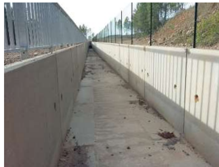
Le canal aérien
